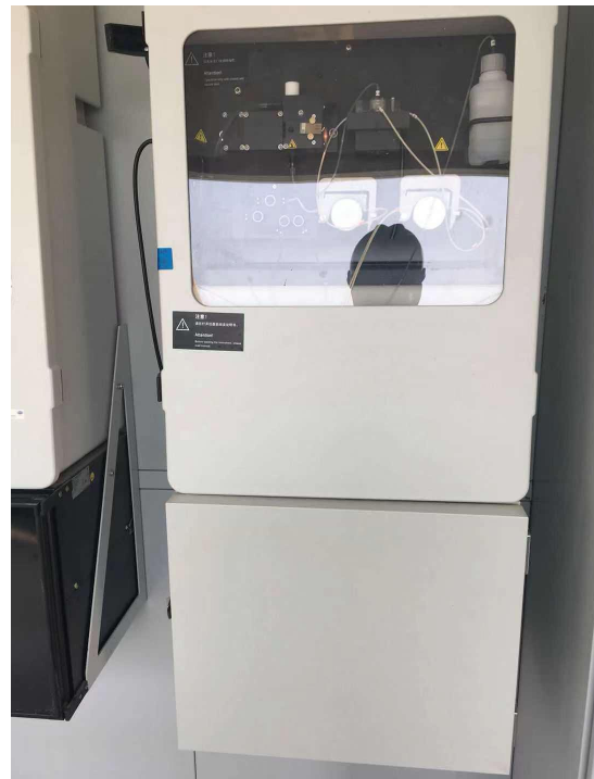
废水总排口-总氮在线
