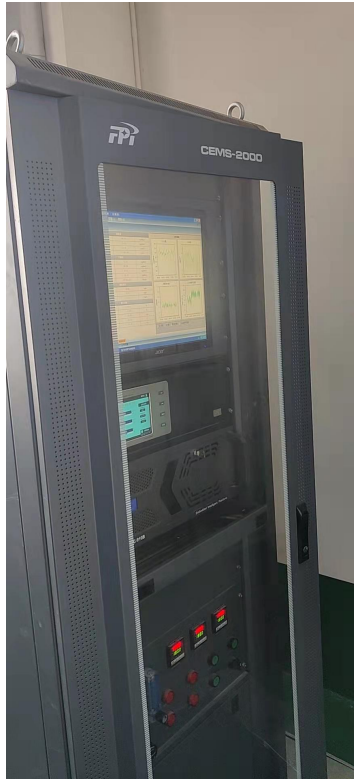
7#RTO 焚烧炉系统在线 CEMS
